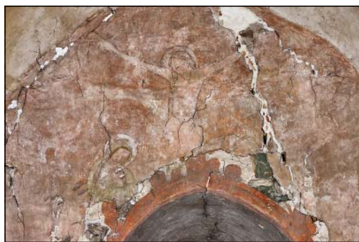
Severní stěna presbytáře, nahoře, Ukřižování.
