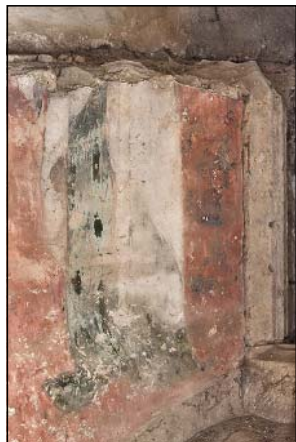
Severní stěna presbytáře, okenní výklenek, fragment postavy světce (světiče?).
